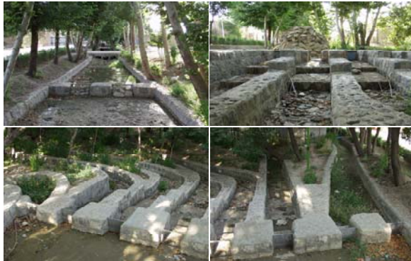
تصویر ۴- عملکرد مادی‌ها به عنوان شبکه تقسیم آب در اصفهان؛ روستای کفشران، مادی که پس از آبیاری باغ محمدعلی‌خان به سمت سایر باغ‌ها می‌رود. عرض شیارها و کانال‌ها بسته به حبابه روستاها متفاوت بوده است.
