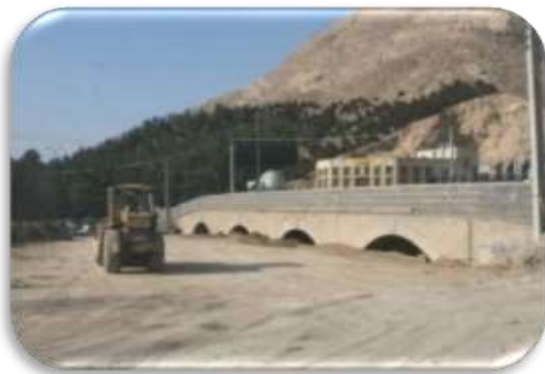
تصویر ۲- احداث پل جدید در جوار پل سرچشمه
