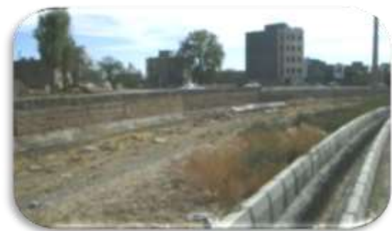
تصویر ۸- دیوار کشی و تبدیل رودخانه به کانال
